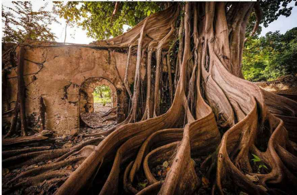
Ruines de l'ancienne prison aux esclaves, détruite au fil du temps par un figuier étrangleur, à Petit-Canal. Aurélien Brusini/hemis.fr
